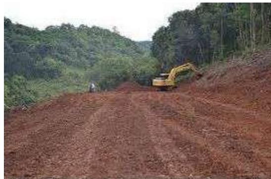
A terraplanagem de grandes áreas exige trator de esteira ou pelo menos trator de pneu com lâmina, retirando-se a terra com caminhões.
