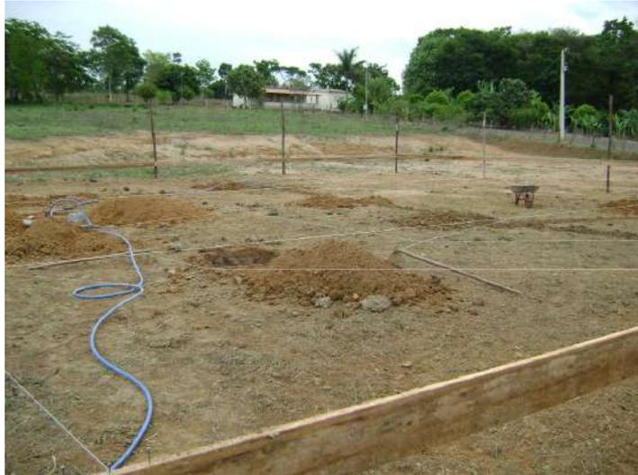
Ilustração de marcação de terreno – Processo da tábua corrida
