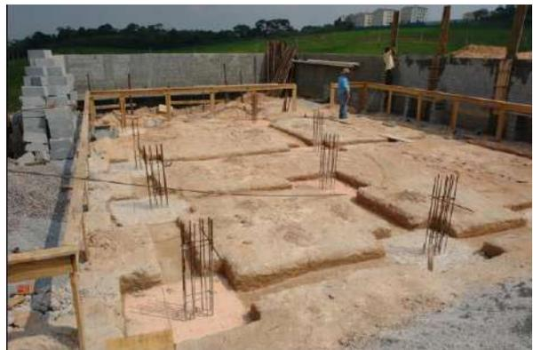
O fato das fundações diretas descontínuas chegarem até 5m de profundidade, faz com que o artifício do uso de brocas sob as sapatas armadas seja comum na maioria das vezes. Isto faz com que o toco de pilar tenha sua profundidade reduzida e a sapata se apoie no leito resistente através das brocas.
