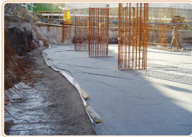
**Figura 4.10: Cura do concreto por recobrimento da estrutura**
