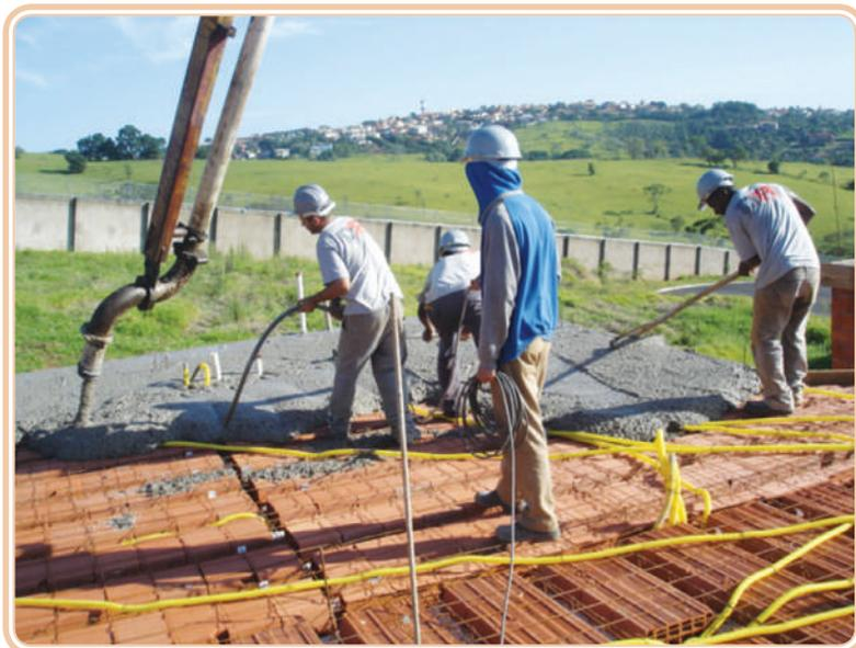
**Figura 4.9: Vibrador de imersão (de agulha)**
