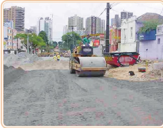
**Figura 4.4: Concreto compactado a rolo**
