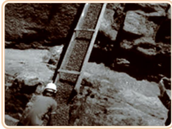
**Figura 4.6: Lançamento de concreto por calhas**
