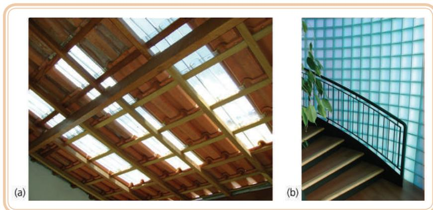
**Figura 7.11: (a) Telhas de vidro em cobertura e (b) divisória com bloco de vidro**
