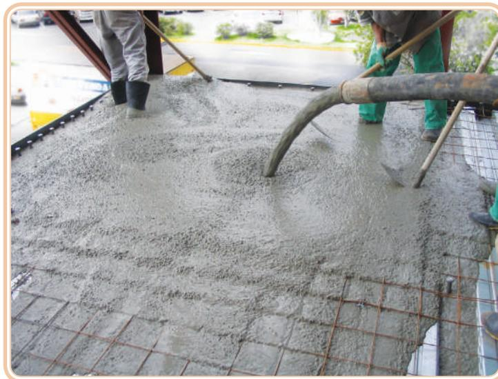
**Figura 4.8: Lançamento de concreto por bombas**
