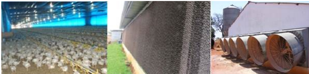
Figura 14. Vista interna e externa de um galpão com sistema adiabático evaporativo.
