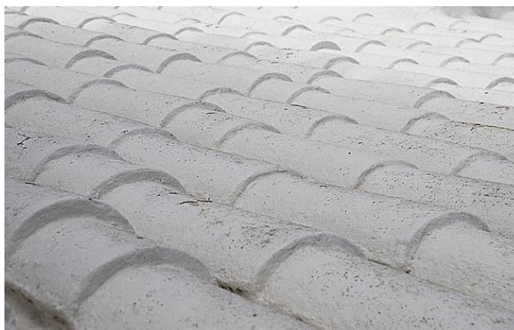
Figura 11. Telhado pintado com cal
