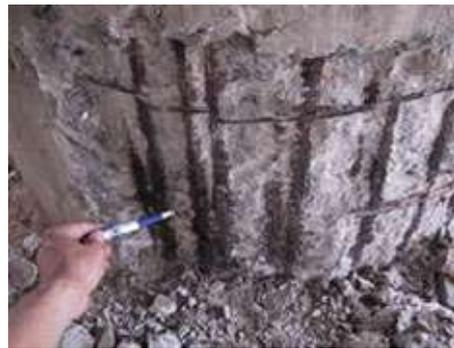
Armação de aço utilizada em concreto armado e armação com corrosão
