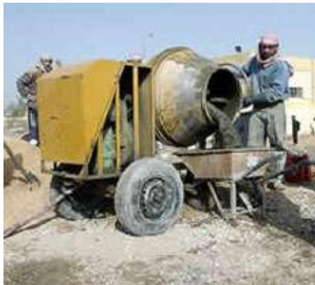
Processo de produção do concreto simples com uso de betoneira
