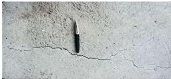
Cura mal feita – trincas no concreto
