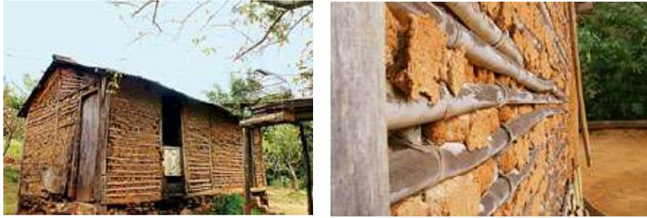
Pau a pique – construção e detalhe construtivo do fechamento
