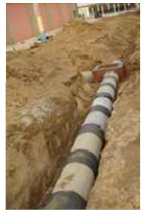
Manilhas de Concreto furado e Poroso, junta asfáltica
